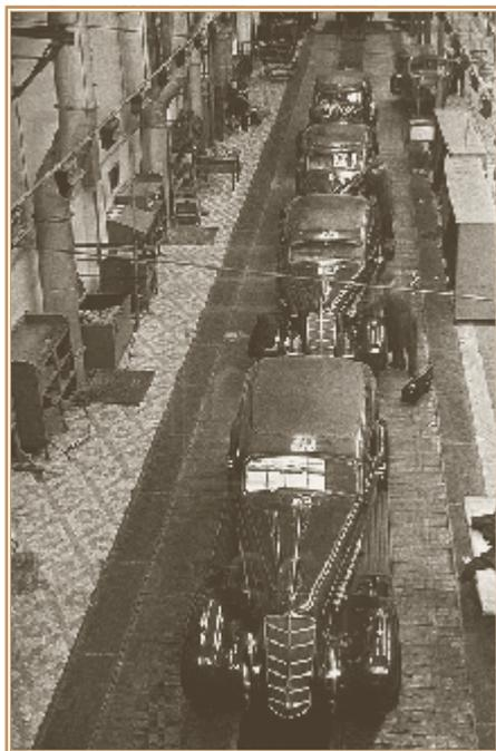
Сборка автомобилей ЗИС-101 на конвейере
